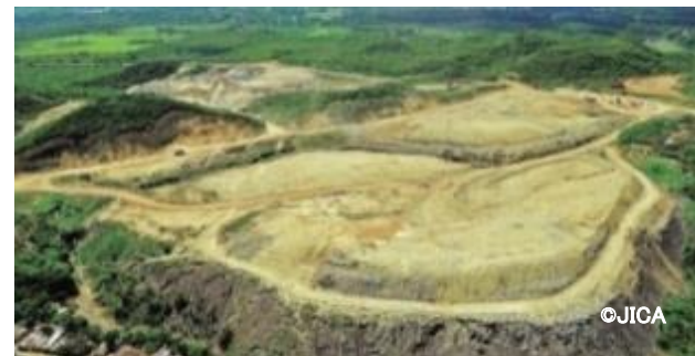
覆土によるごみの飛散流出を防止
