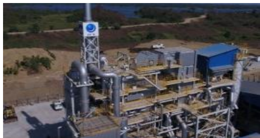
廃棄物発電施設
